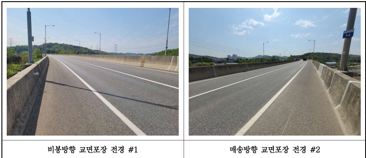
【사진 1.3.22】 교면포장 전경
