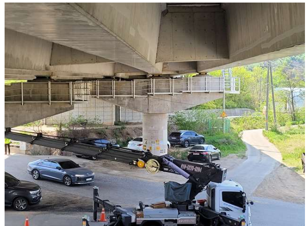
교각 P1 전경
