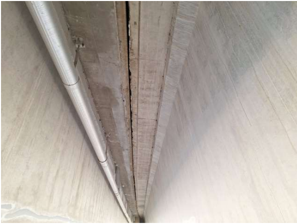
바닥판하면 S1 캔틸레버부 전경
