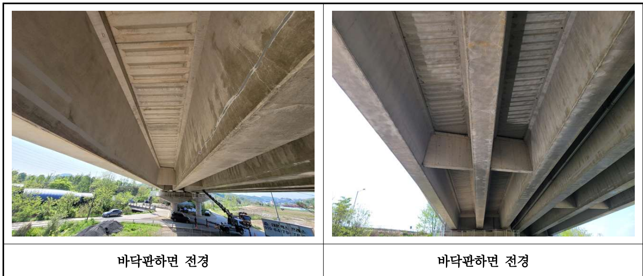
【사진 1.3.2】 바닥판하면 전경
