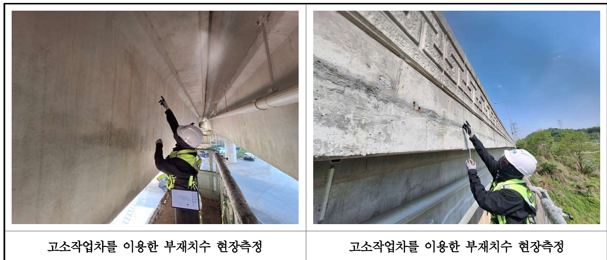
【사진 1.2.2】 부재 현장측정 전경
