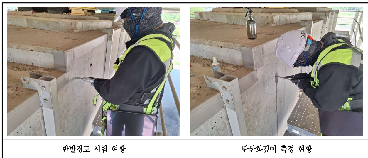
【사진 1.4.1】 콘크리트 내구성조사 현황
