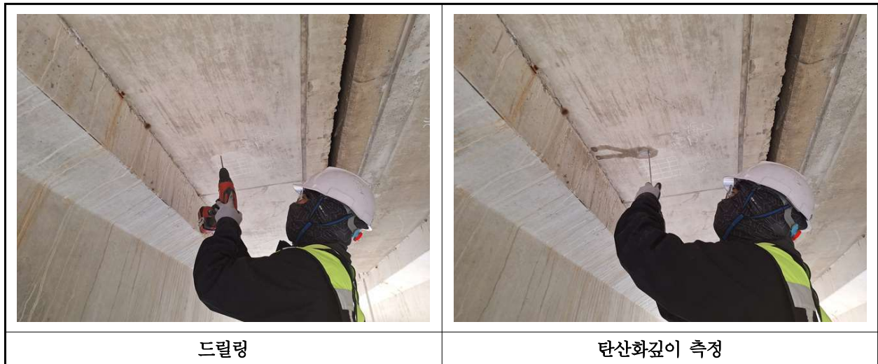
【사진 1.4.3】 탄산화 깊이 측정 현장사진
