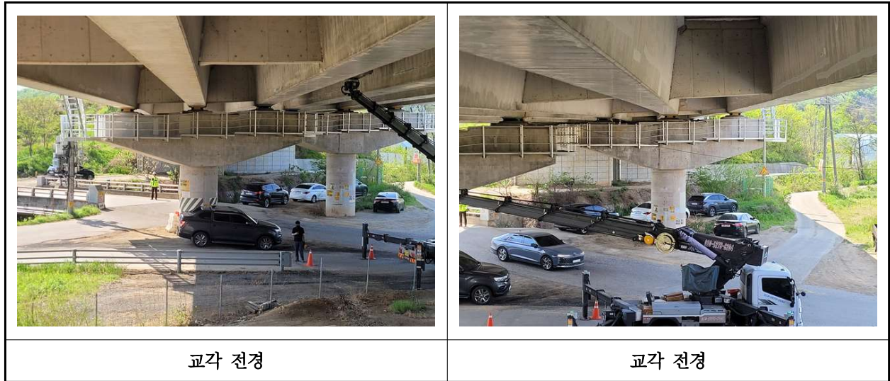
【사진 1.3.11】 교각 전경
