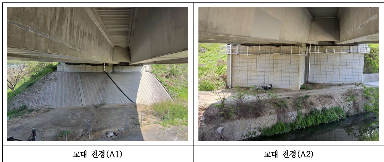
【사진 1.3.8】 교대 전경
