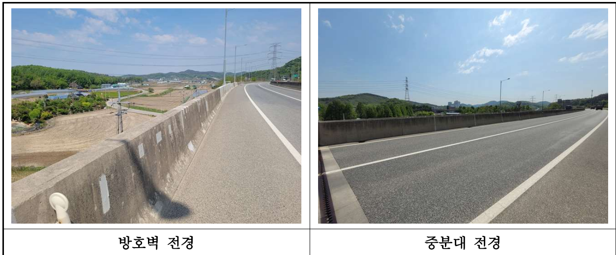
【사진 1.3.27】 방호벽 및 중분대 전경
