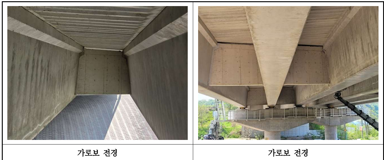
【사진 1.3.6】 가로보 전경
