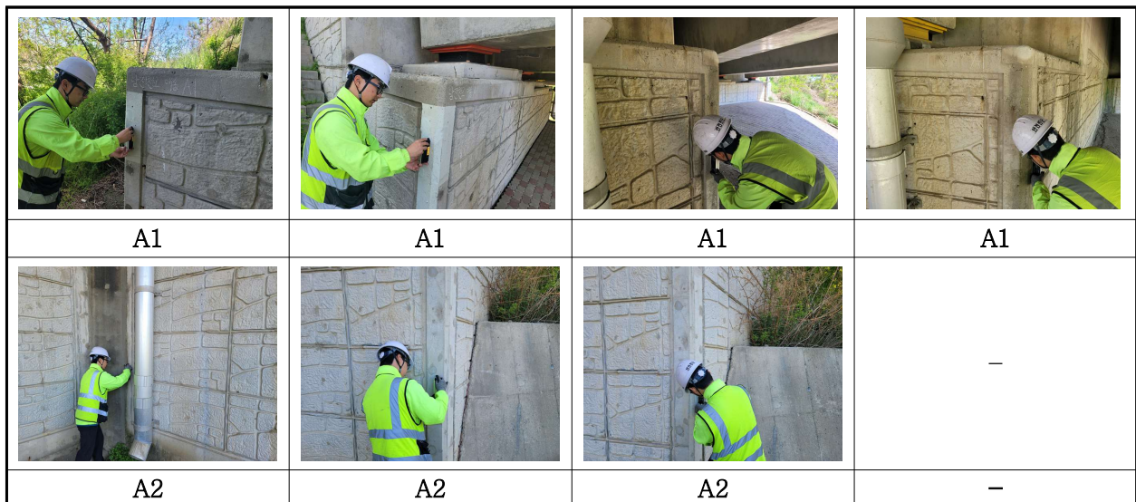
【사진 1.3.10】 교대 기울음 측정 현황
