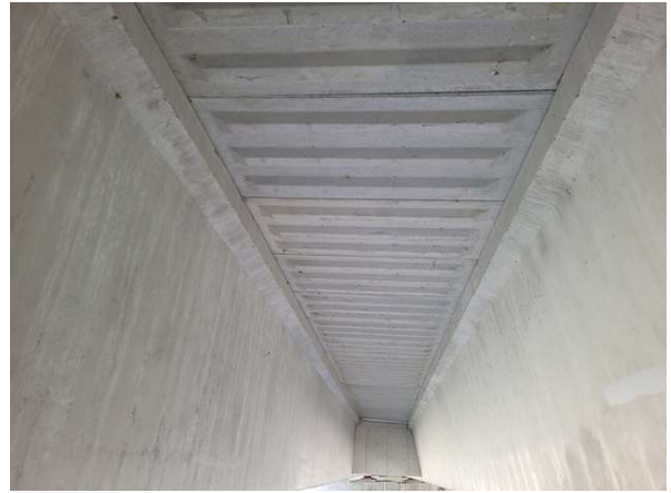
바닥판하면 S2 전경
