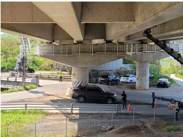
교각 P1 전경
