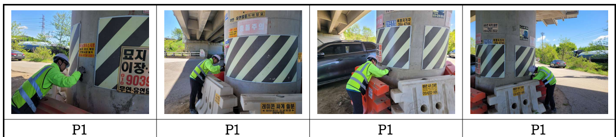
【사진 1.3.13】 교대 기울음 측정 현황
