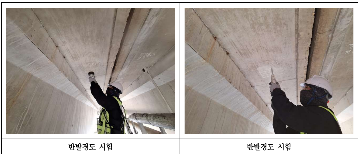
【사진 1.4.2】 반발경도시험 현장사진
