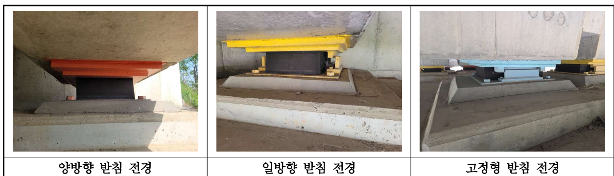
【사진 1.3.15】 교량받침 전경
